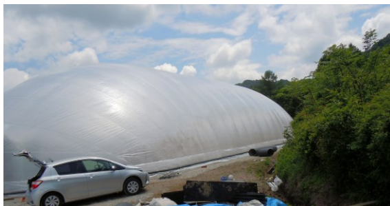
エアードーム式温室
